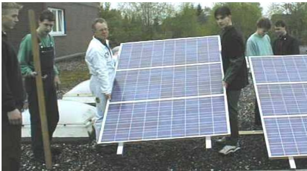
Lehrer Alfred Roßkamp und seine Schüler sind dem Gebäude aufs (Flach)- Dach gestiegen: Sie haben eine 1000 Watt starke Photovoltaik-Anlage installiert, die Sonnenenergie in Strom umwandelt und direkt ans Netz abgibt. Eine weitere Leitung haben die Schüler zum EDV-Raum verlegt. So wird mindestens einmal in der Woche via Internet ans Fraunhofer-Institut übermittelt, wie viel Strom die Fozellen auf dem Dach erzeugen.
